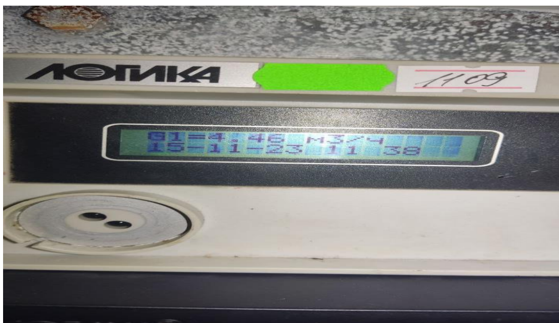
Рис.6. Узел учет. Тепловычислитель.
